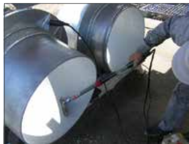
ピンホール検査 / Pinhole Inspection
