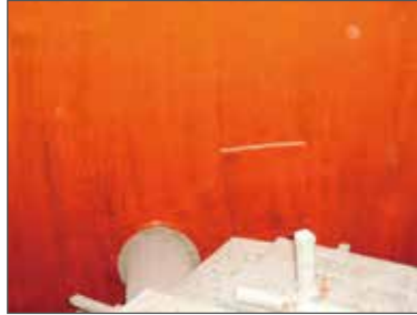
プライマー塗布 / After Primer Coating
