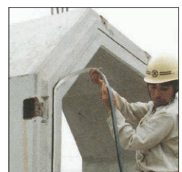
ボックスカルバート Box culvert
