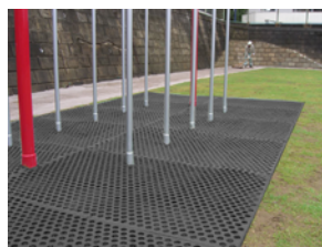
学校遊具下の芝保護施工直後
