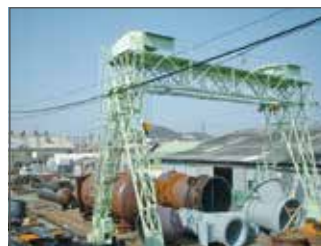
門型走行クレーン Gate Type Hoist Crane
