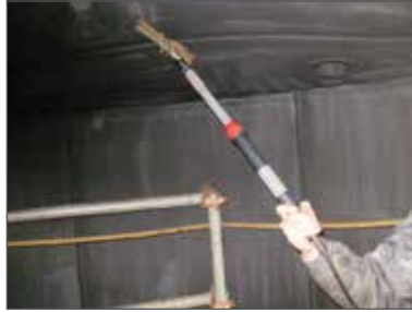
ピンホール検査 / Pinhole Inspection
