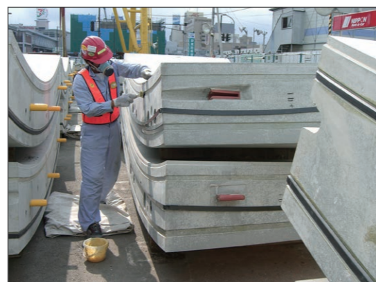
アクアケルシーラーの貼り付け Application of AQUAQUELL SEALER
