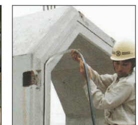
ボックスカルバート Box culvert
