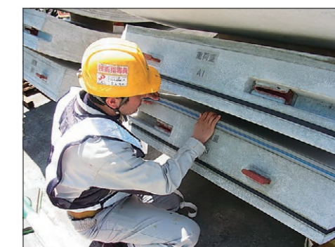
アクアOJコーキングの貼り付け Applicatuin of AQUA OJ CAULKING
