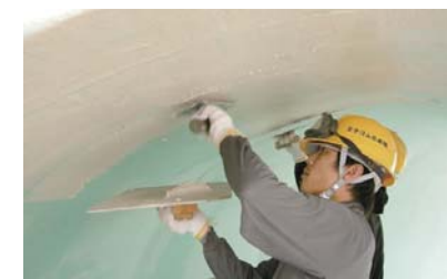
フレックライニング施工 Flake Lining Application
