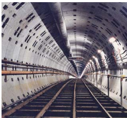
シールドトンネル The Channel Tunnel (Shield Tunnelling Method)
