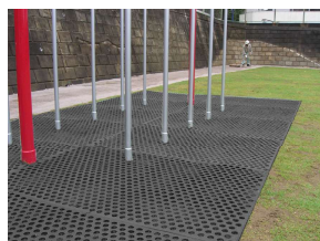
学校遊具下の芝保護施工直後
