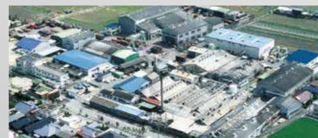
本社工場 / Head Office & Factory
