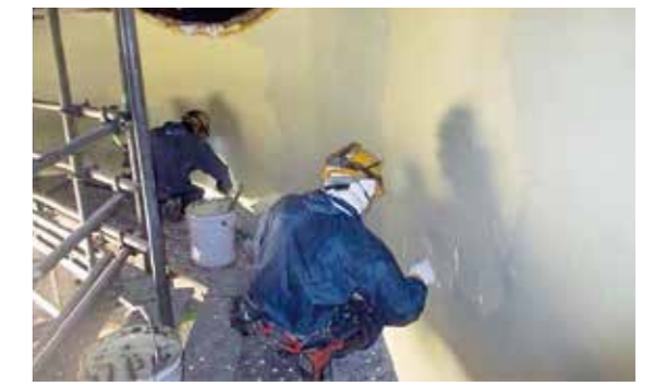
フレークライニング施工 Flake Lining Application
