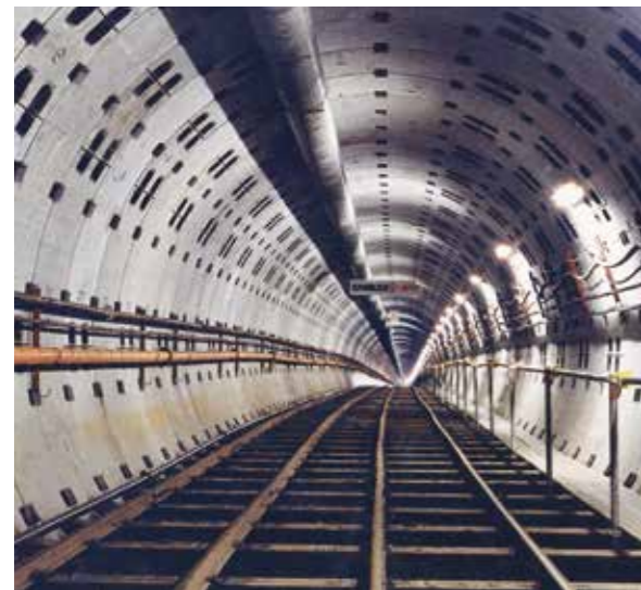
シールドトンネル The Channel Tunnel (Shield Tunneling Method)
